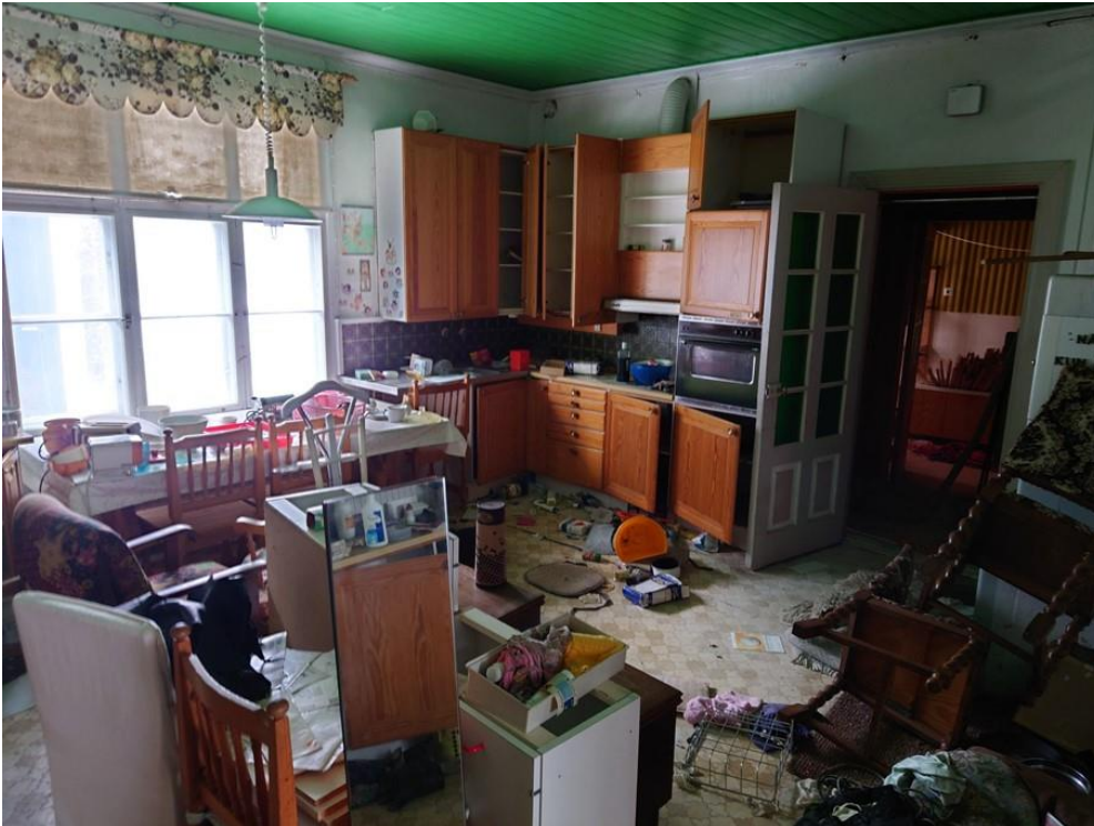
Kuva 1) Keittiössä havaittiin asbestipitoista lattiamatotusta.
